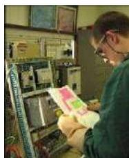
On doit comparer le type et le nombre de contacts utilisés avec ceux prévus dans la fiche des références matériels. On vérifie le nombre de contacts raccordés dans le coffret et sur la porte.
