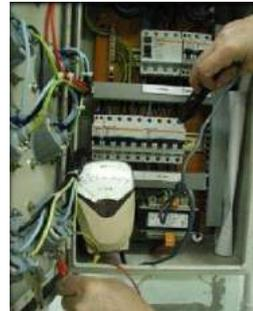
**6<sup>ème</sup> étape : Vérification de l'alimentation et des couplages des moteurs.**
