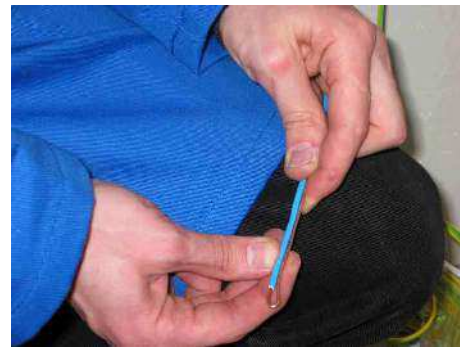
3. Le retourner en son bout en faisant une boucle.
