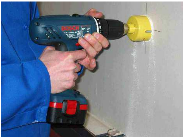
5. Perçage en gardant l'alignement vertical et horizontal
