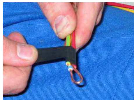
5. Faire, au moins sur 5 cm de longueur, des tours de chatterton pour maintenir les conducteurs entre eux.
